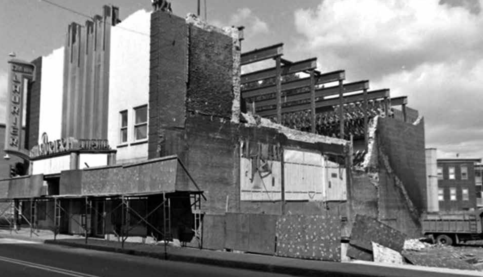
Démolition du Cinéma Laurier (Archives Ville de Québec – 18 septembre 1974)
