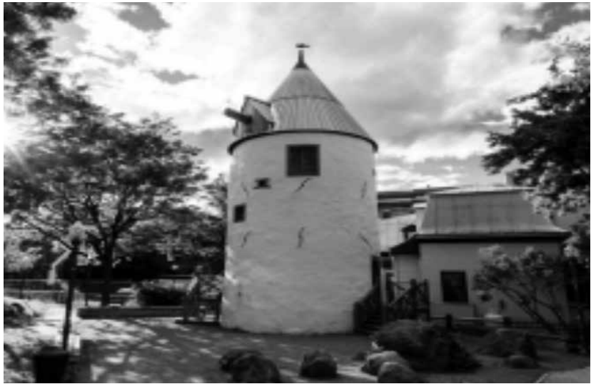
La tour du moulin à vent après les travaux de 2014 (Photographie de la Ville de Québec).
